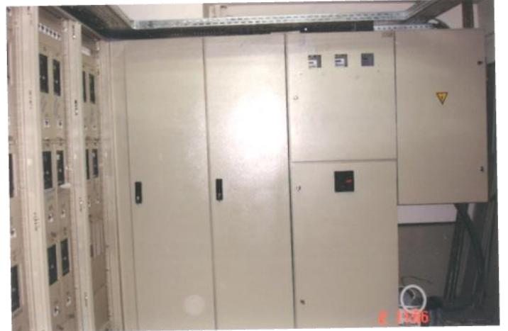
Jeneratör Transfer Panosu
